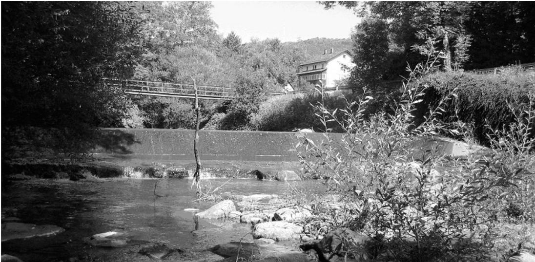
Foto 3: Zustand nach teilweiser Beseitigung des Betonwehrs
