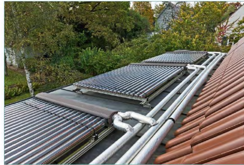
Blick auf das südlich angeschleppte Flachdach mit Kollektoranlage
