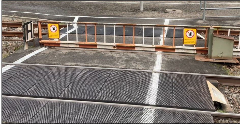
Abbildung 6: geschlossene Schiebeschranke mit Warnschildern
