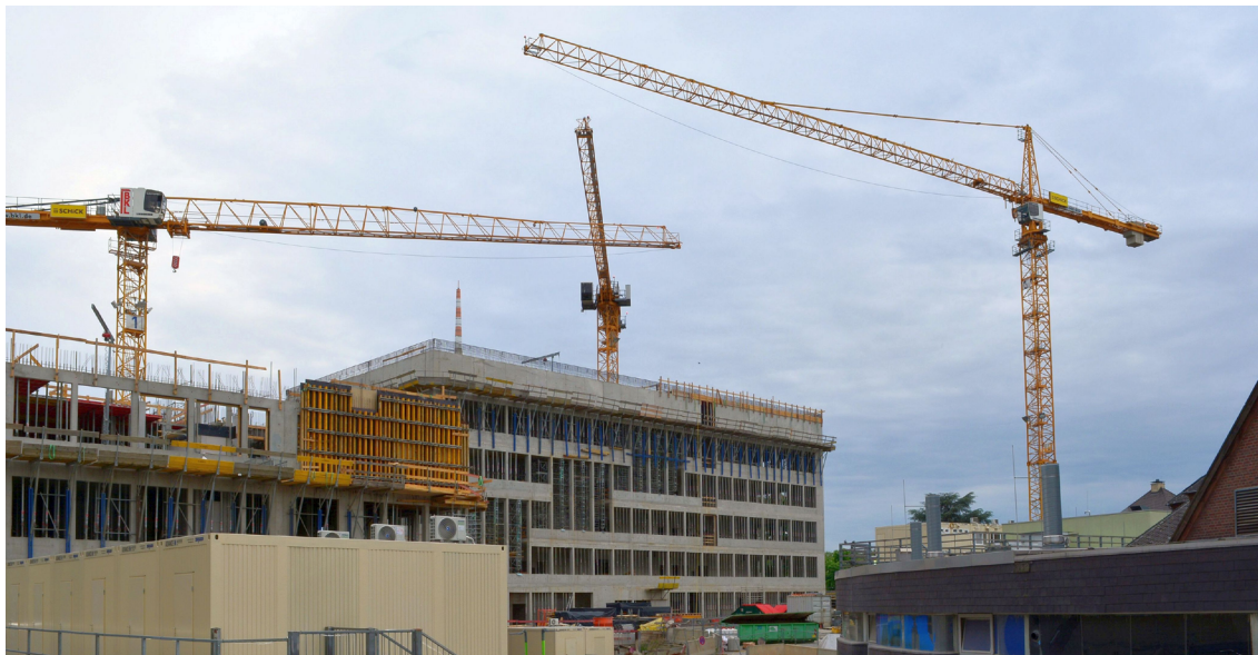
Abbildung 24-5: Baustelle MaReCum am Universitätsklinikum Mannheim
