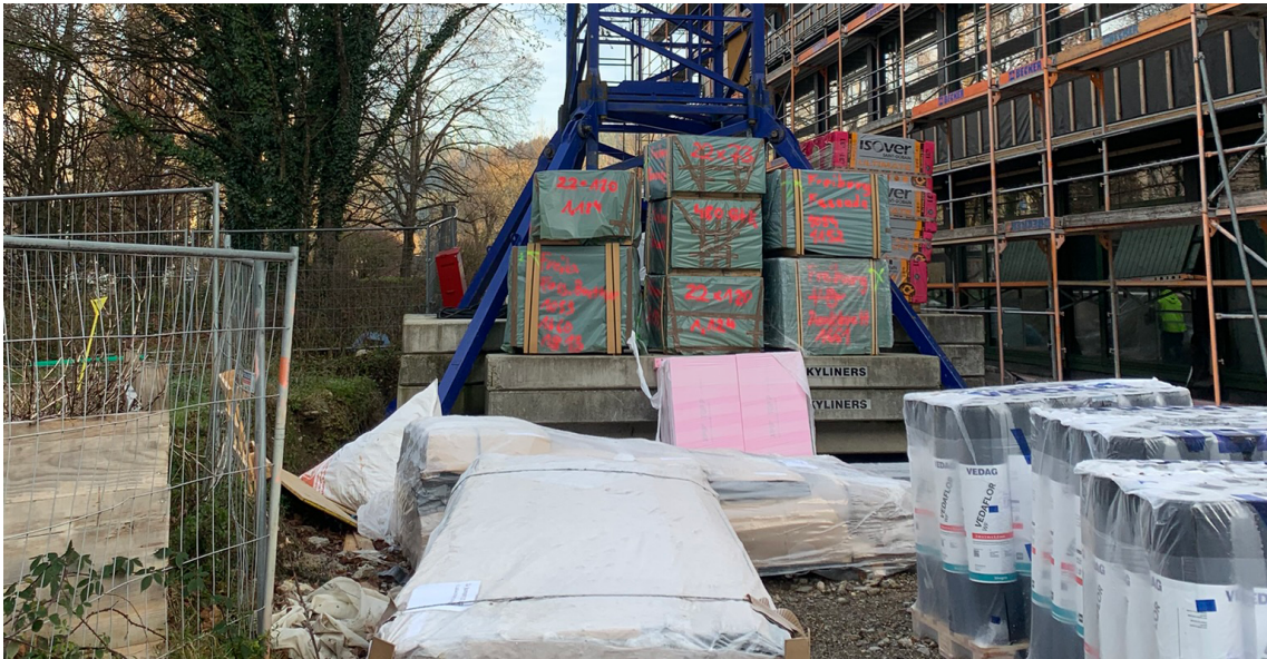
Abbildung 24-3: Sehr beengte, innerstädtische Baustelle (Pädagogische Hochschule Freiburg)
