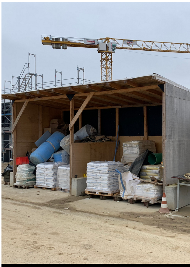
Abbildung 24-4: Unternehmensspezifische Baustelleneinrichtung (Justizvollzugsanstalt Rottweil)
